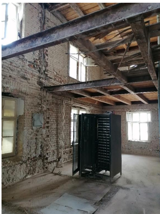
Obnova zgrade u ulici R. Austrije 18
