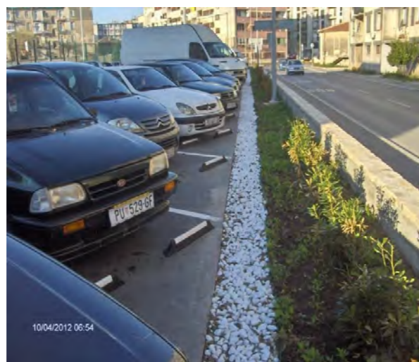
Slika 83 Infiltracijski jarci parkirališta (autorska fotografija)
