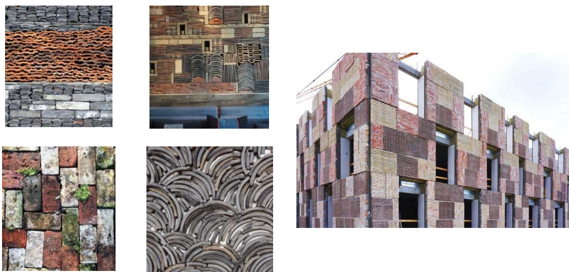
Slika 6. Sekundarna upotreba građevnih materijala i proizvoda (ugradnja uklonjenih elemenata na drugu poziciju)
