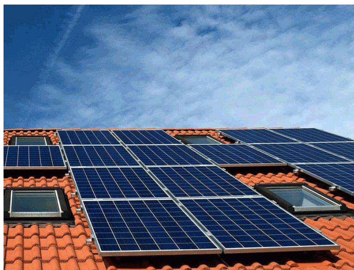
Slika 10 Primjer fotonaponskog panela instaliranog na krovu
