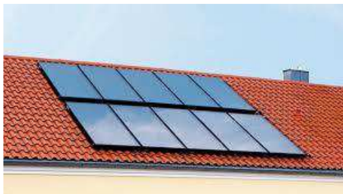
Slika 12 Primjer pločastog toplovodnog solarnog kolektora
