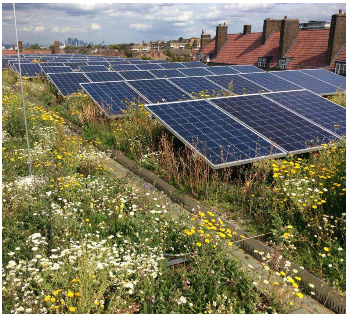
Slika 13 Biosolarni krov na stambenim zgradama u naselju Clapham
