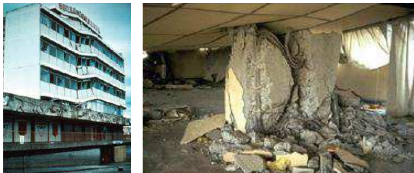
Slika 8.3 Primjer razarajućeg efekta torzije (44)
