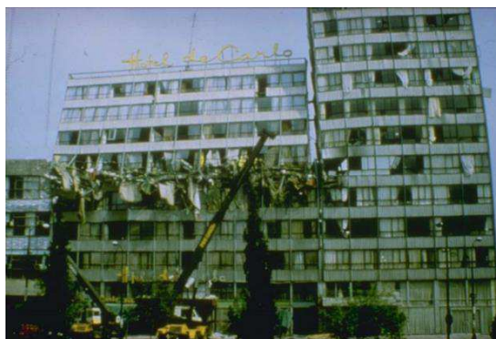
Slika 8.10 Otkazivanje zgrade zbog sudaranja prilikom potresa u Mexico City-u 1985. godine (49)
